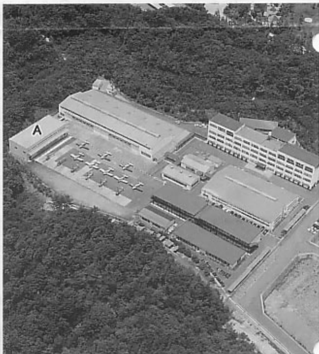
学校施設全景（新たに増築された第二格納庫A）
